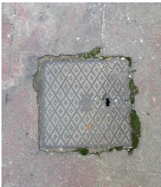
Fot. 1 Zdjęcia istniejących pokryw żeliwnych włazów studni i pomieszczenia komory silnika w pierwotnym barwionym betonie, zbiory własne, sierpień 2024.
