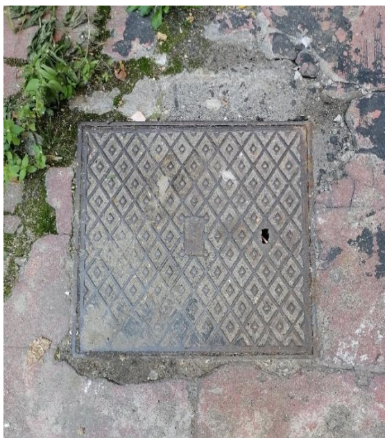
Fot. 1 Zdjęcia istniejących pokryw żeliwnych włazów studni i pomieszczenia komory silnika w pierwotnym barwionym betonie, zbiory własne, sierpień 2024.
